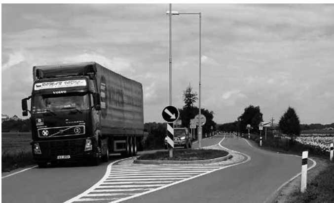
Obr. 3 Zvýraznění změny funkce pozemní komunikace pomocí oboustranně vychýleného ostrůvku na vjezdu do obce – příklad fyzického zklidnění, které bývá často považováno za samovysvětlující utváření
