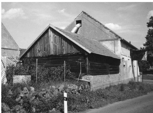
Obr. 31 Krakov, okr. Rakovník, čp. 9: hospodářská stavba zbudovaná drážkovou konstrukcí. Foto Z. Sklenářová 2003. – Abb. 31 Krakov, Bez. Rakovník, Konstr.-Nr. 9: Wirtschaftgebäude in Pfosten-Nut-Konstruktion. Aufnahme Z. Sklenářová 2003.
