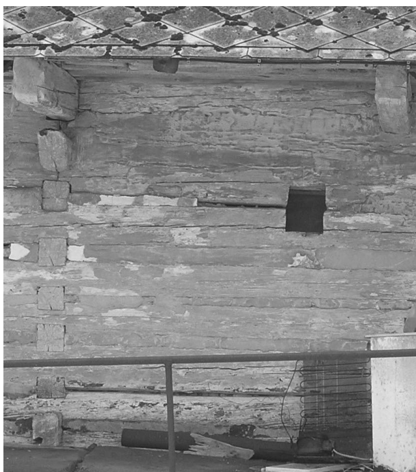
Obr. 72 Dědkov, okr. Benešov, čp. 3: a – v boční stěně omítnutého roubeného stavení je patrné okénko na sílu trámu v černé kuchyni vedle pece, b – totéž okénko zevnitř, c – způsob vyříznutí okénka v roubené stěně. Foto Z. Sklenářová 2004. – Abb. 72 Dědkov, Bez. Benešov, Konstr.-Nr. 3: a – in der Längsseite des verputzten Blockhauses ist ein kleines balkenhohes Fenster in der Rauchküche neben den Backofentüren zu sehen, b – dasselbe Fenster von Innen, c – die Weise der Erarbeitung des Fensters in der Blockwand. Alle Aufnahmen Z. Sklenářová 2004.
