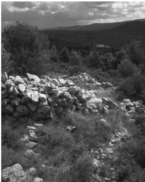
Obr. 51 Skořepinová zeď: plenty z hrubých kusů vápence a výplň z drobně sypaného kamení. Stari Grad, ostrov Hvar, Chorvatsko – hraniční zídky zaniklých polí a zahrad. Foto Z. Sklenářová 2000. – Abb. 51 Schalenmauer: die Seiten sind trockengemauert, das Kern aus dem kleineren Gestein eingeschüttet. Stari Grad, Insel Hvar, Kroatien – Umfangsmauer der vergangenen Feldern und Gärten. Aufnahme Z. Sklenářová 2002.
