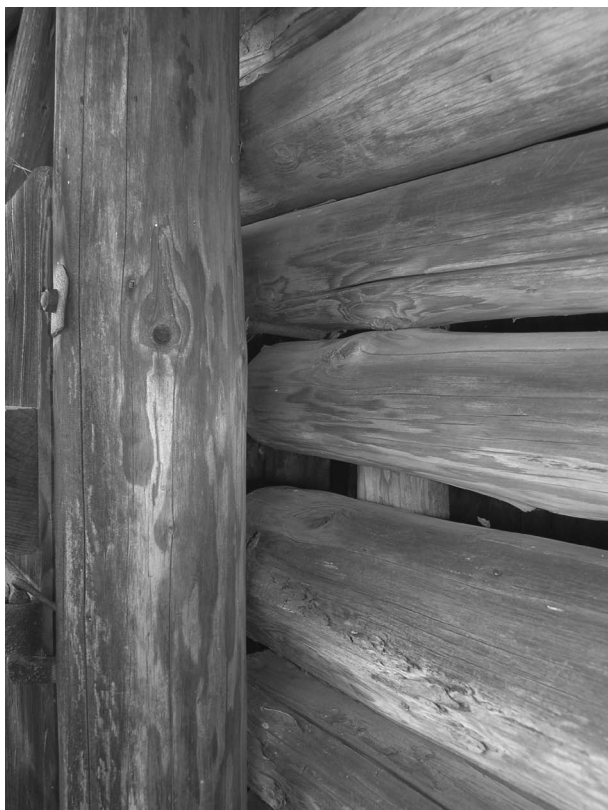
Obr. 45 Vysoká u Kosovy Hory–Dobrohošť, okr. Příbram, seník u čp. 2. Jižní stěna zbudovaná kleštinovou konstrukcí. Krov nese konstrukce přístěnných sloupků, sloupky fungují zároveň jako stěnové kleštiny. Mezerami ve výplni je vidět vnitřní stěnová kleština. Foto Z. Sklenářová 2004. – Abb. 45 Vysoká u Kosovy Hory–Dobrohošť, Bez. Příbram, Heuscheune beim Anwesen Kongskr.-Nr. 2. Die in der Zangenkonstruktion erbaute Südwestwand. Die Ständer tragen das Dachgerüst und zugleich als Zangen dienen. Durch die Fugen in der Stangenfüllung ist der innere Ständer des Zangenpaars zu sehen. Aufnahme Z. Sklenářová 2004.
