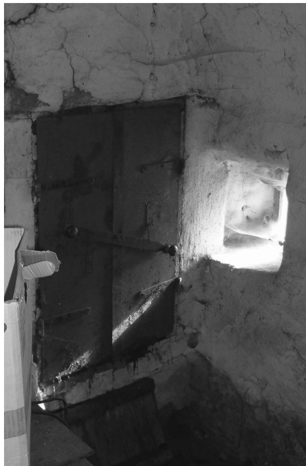
Obr. 72 Dědkov, okr. Benešov, čp. 3: a – v boční stěně omítnutého roubeného stavení je patrné okénko na sílu trámu v černé kuchyni vedle pece, b – totéž okénko zevnitř, c – způsob vyříznutí okénka v roubené stěně. Foto Z. Sklenářová 2004. – Abb. 72 Dědkov, Bez. Benešov, Konstr.-Nr. 3: a – in der Längsseite des verputzten Blockhauses ist ein kleines balkenhohes Fenster in der Rauchküche neben den Backofentüren zu sehen, b – dasselbe Fenster von Innen, c – die Weise der Erarbeitung des Fensters in der Blockwand. Alle Aufnahmen Z. Sklenářová 2004.
