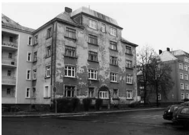
Obr. 6 Ústí nad Labem, ulice Čajkovského od Z, současný snímek laténské lokality (nahore); ulice Malířský koutek od J (uprostřed); ulice Kozinova od JZ (dole); (foto J. Waldhauser). – Fig. 6 Ústí nad Labem, Čajkovského street, from west, contemporary picture of Latène site (above); Malířský koutek street from south (in the middle); Kozinova street from south-west (below); (photograph by J. Waldhauser).
