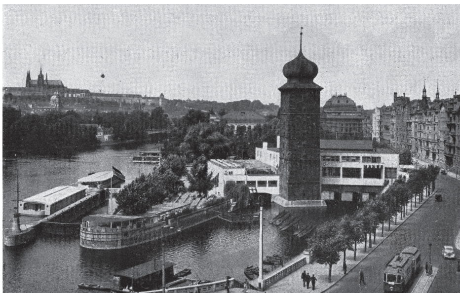
Obr. 3: Na pohlednici můžeme na místě Šitkovských mlýnů již vidět budovu uměleckého spolku Mánes a o několik metrů zvýšené nábřeží proměněné v reprezentativní promenádu. Zdroj: archiv autorky
