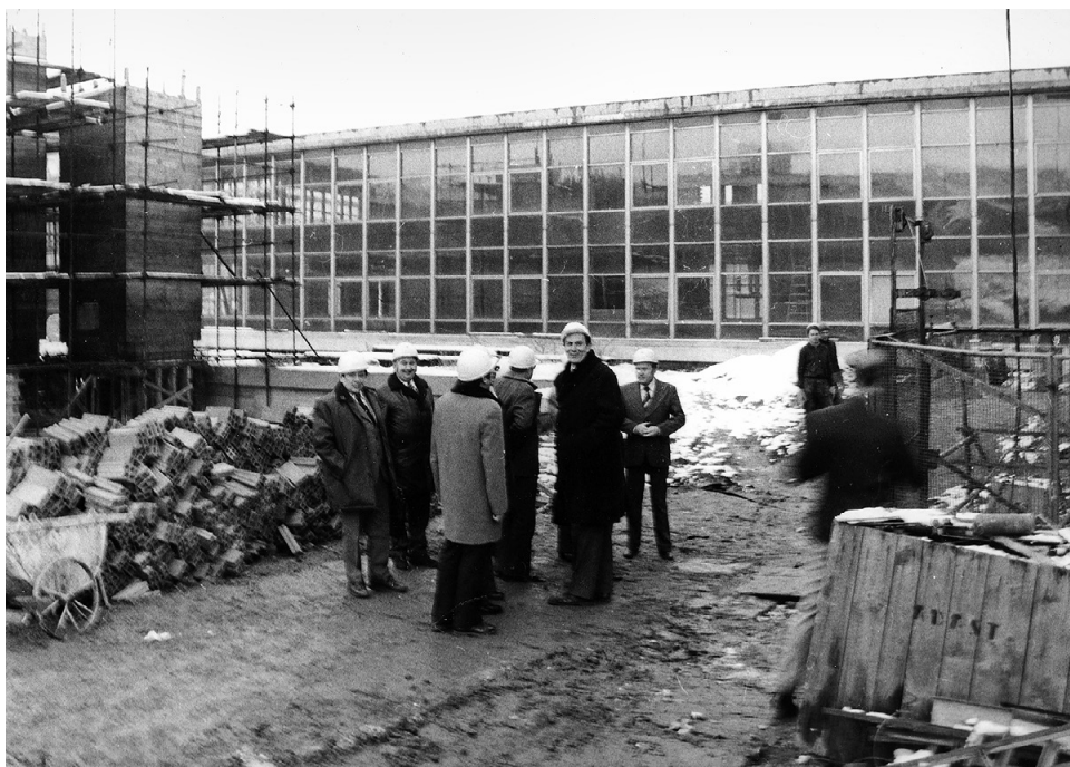
Obr. 3: Návštěva stavby areálu MFF, 13. 12. 1976 (AUK, fond Fotoarchiv, události)
