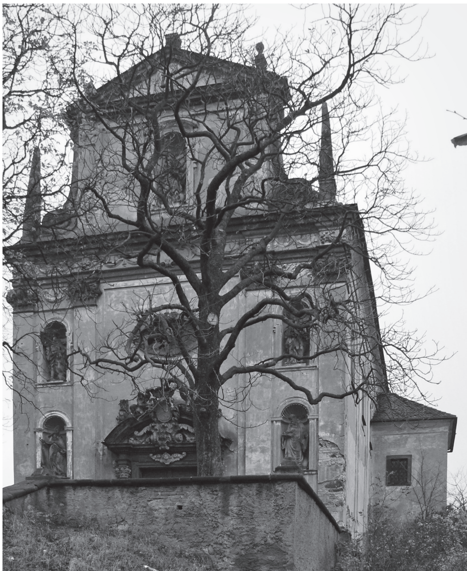
Obrázek 1. Antonio Porta, kostel sv. Antonína Paduánského v Milešově, 1669–1680, vstupní průčelí, foto: Jakub Pátek
