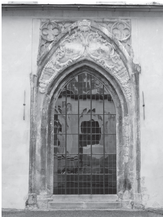
Obrázek 2. Zlatá Koruna, cisterciácký klášter, fragmenty bývalého studničního stavení – čelní pohled z rajského dvora (ze západu), foto: archiv autora, 2021
