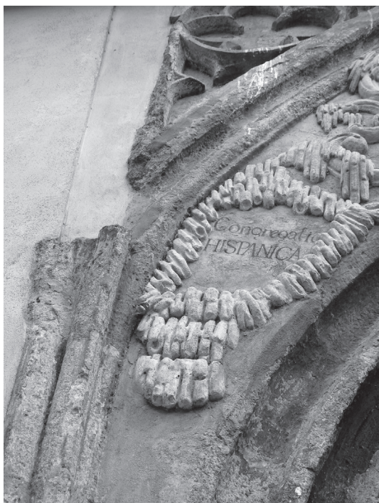
Obrázek 5. Zlatá Koruna, cisterciácký klášter, detail severní interiérové přípory bývalého studničního stavení s náběhem přizdílného cviklu někdejšího stropního řešení, foto: archiv autora, 2021
