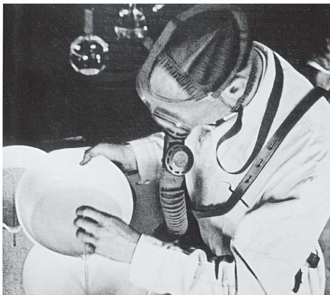
Obr. 9: Maska s filtrem jako ochrana před vdechováním radonu při plnění radioforů v laboratoři jáchymovské radiové továrny [ Radium – Jáchymov – Československo , Praha 1932]
