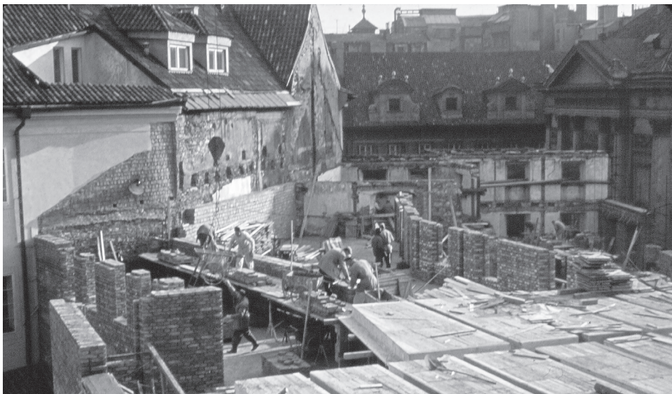
Obr. 5: Stavba budovy Archivu v Karolinu, zdění III. patra, šalování stropu nad II. patrem (vlevo dnešní místnost č. 501, vpravo místnost depozitáře), 10. 12. 1965 (AUK, fond Obnova Karolina, dar stavitele Jana Lopaty, sig. LOP-546)
