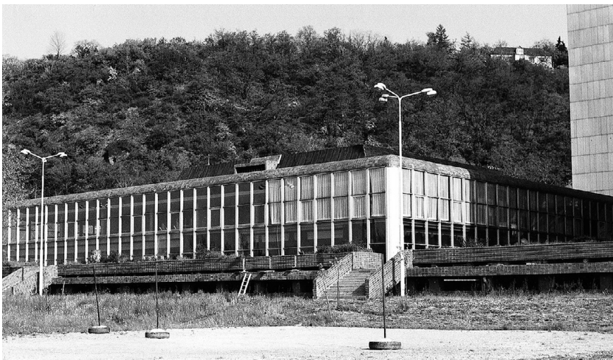
Obr. 6: Menza 17. listopadu, datace asi 1992 (AUK, fond RUK, zaměřený stav stavebních objektů, Areal 01-Pelc-Tyrolka)
