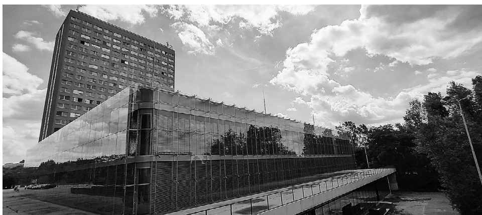
Obr. 8: Budova koleje A a budova FHS (foto autor, 2023)
