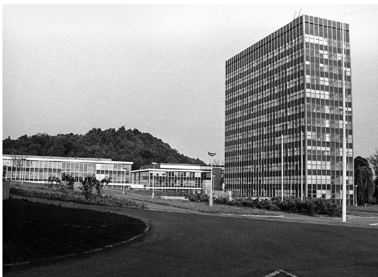
Obr. 2: Pohled na dokončený areál MFF, s. d., odhad po r. 1978 (AUK, fond Fotoarchiv, budovy, MFF)
